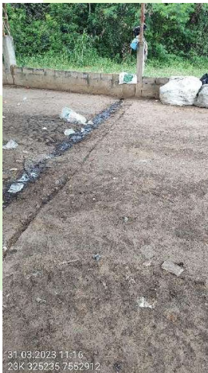
Foto 8, Foto 9 e Foto 10 – Área com piso impermeável e drenagem para uma caixa de contenção.
