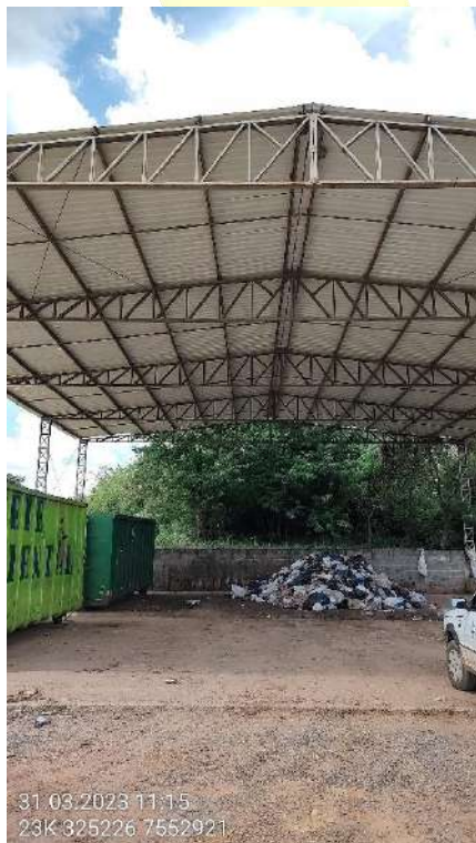
Foto 8, Foto 9 e Foto 10 – Área com piso impermeável e drenagem para uma caixa de contenção.
