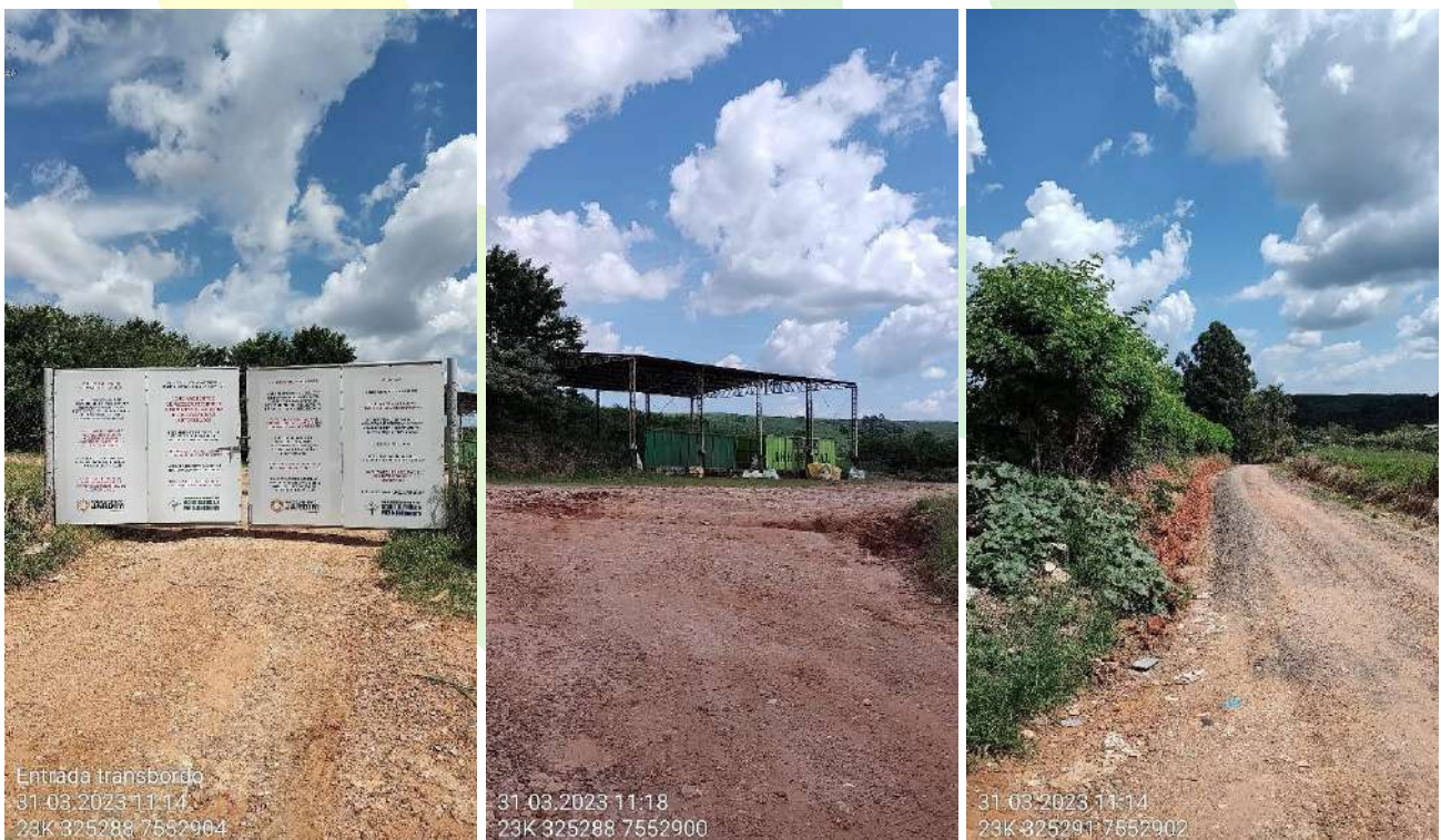
Foto 4 - Entrada da área do transbordo sendo fechada e com sinalização recém reformada. Foto 5 – Vista do Galpão instalado em 2020. Foto 6 - O perímetro se encontra cercado por tela além de cerca viva.
