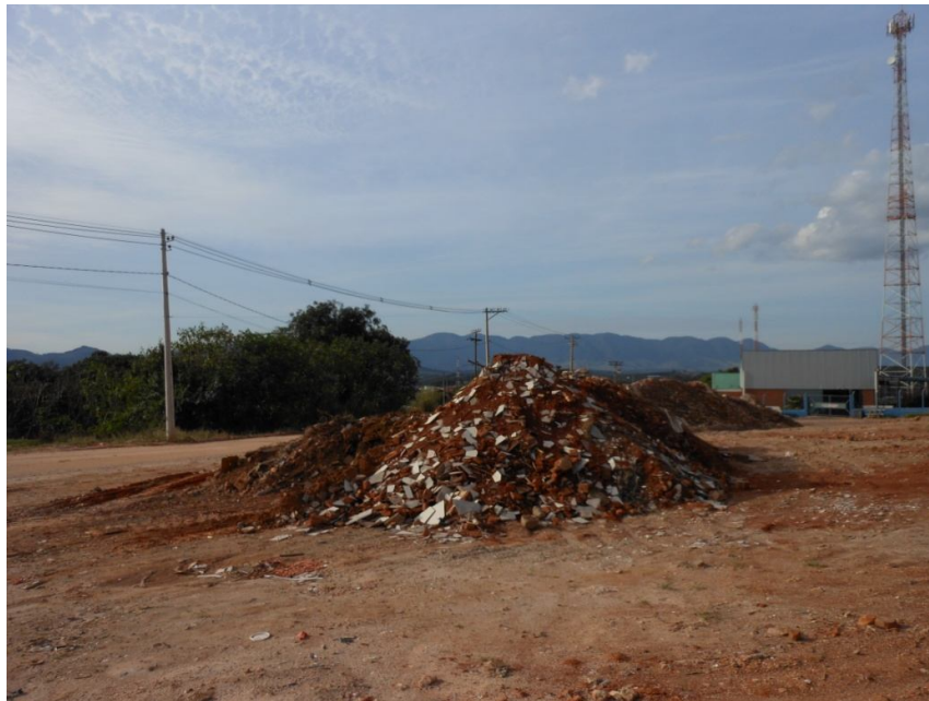
Foto 17: Resíduos de construção civil.
