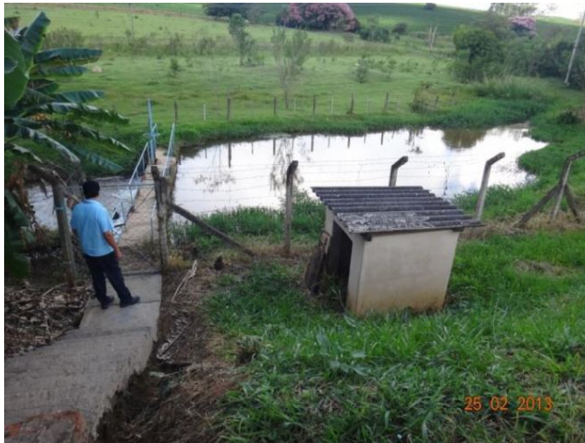
Foto 24: Barragem de nível - captação Ribeirão Jardim.
