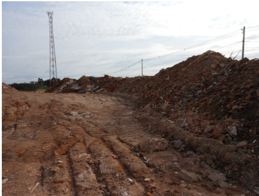
Foto 16: Área de disposição de resíduos de construção civil.
