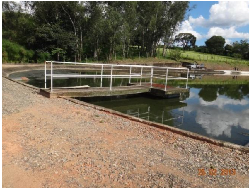
Foto 27: Saída do esgoto tratado - Lagoa Facultativa.
