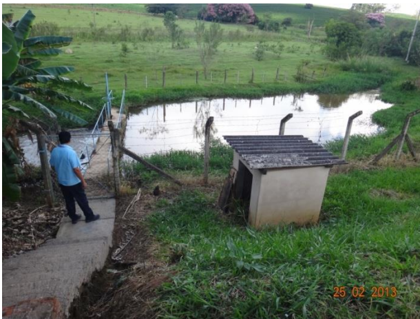
Foto 4.1- Barragem de nível - captação Ribeirão Jardim.
