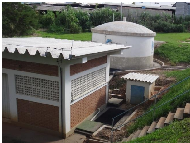
Foto 4.8 - EEAT1 e RA1
