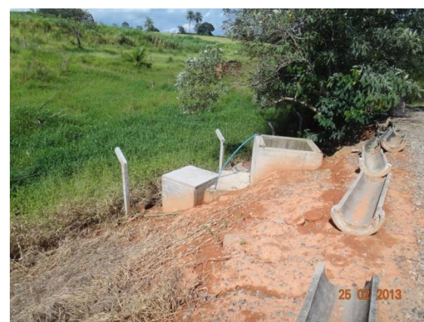
Foto 4.12 - Caixa de saída antes do emissário final
