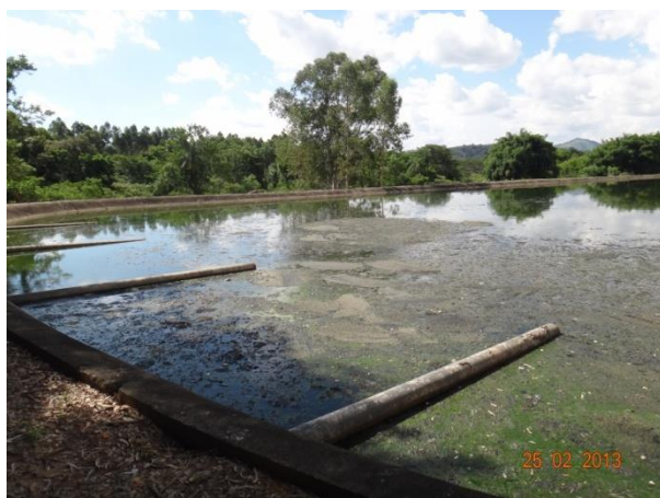
Foto 4.9 - Entrada do esgoto bruto - Lagoa Facultativa
